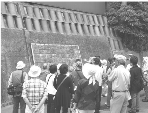
土管でつくられた塀(常滑)12年6月
